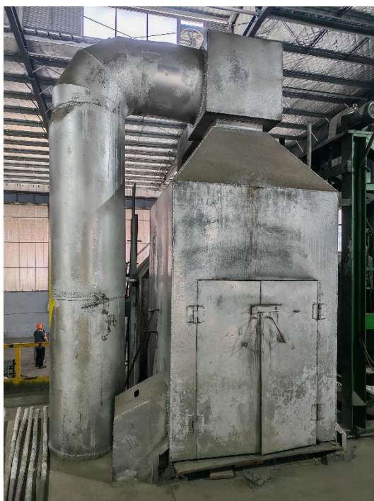
熔化炉废气收集方式
